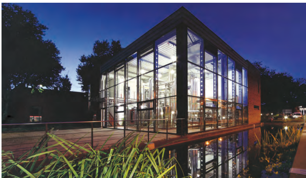
Foto: BOGESTRA, Energiezentrale Straßenbahnbetrieb und Strab-Werksatt Engelsburg
