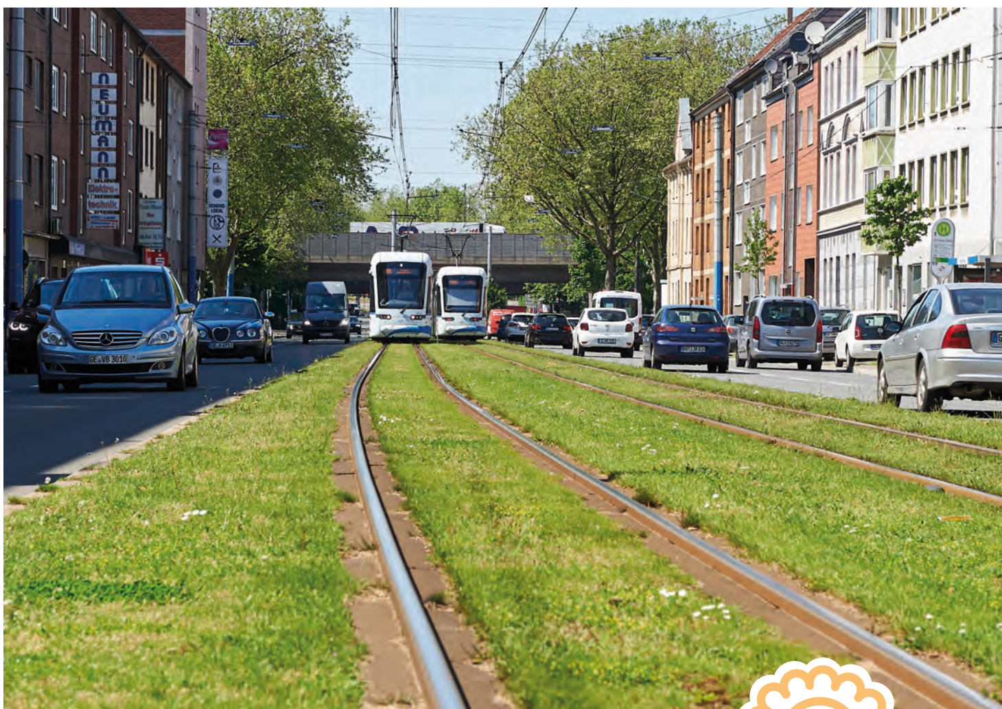
Foto: BOGESTRA, Rasengleis Schalker Meile
