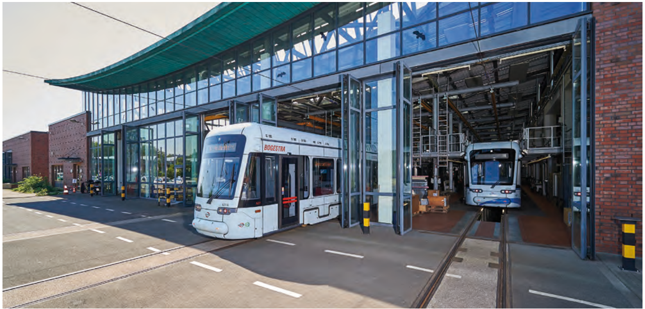
Foto: BOGESTRA, Straßenbahnbetrieb und Strab-Werkstatt Engelsburg
