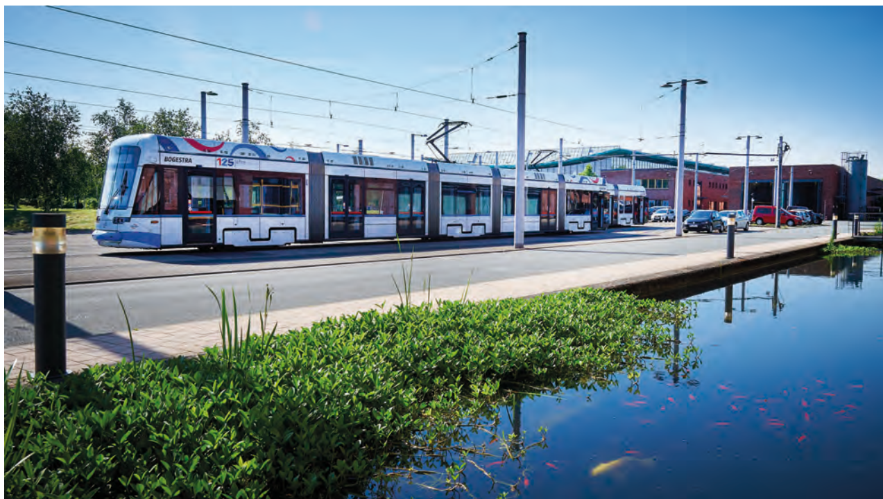
Foto: BOGESTRA, Straßenbahnbetrieb und Strab-Werkstatt Engelsburg
